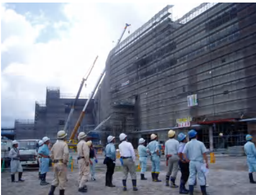
現場見学会・技術者講習会 場所：イオンSC建築現場
