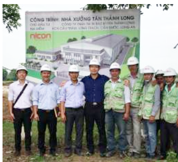
▲ベトナム現地へ社員を派遣、施工管理を実施
